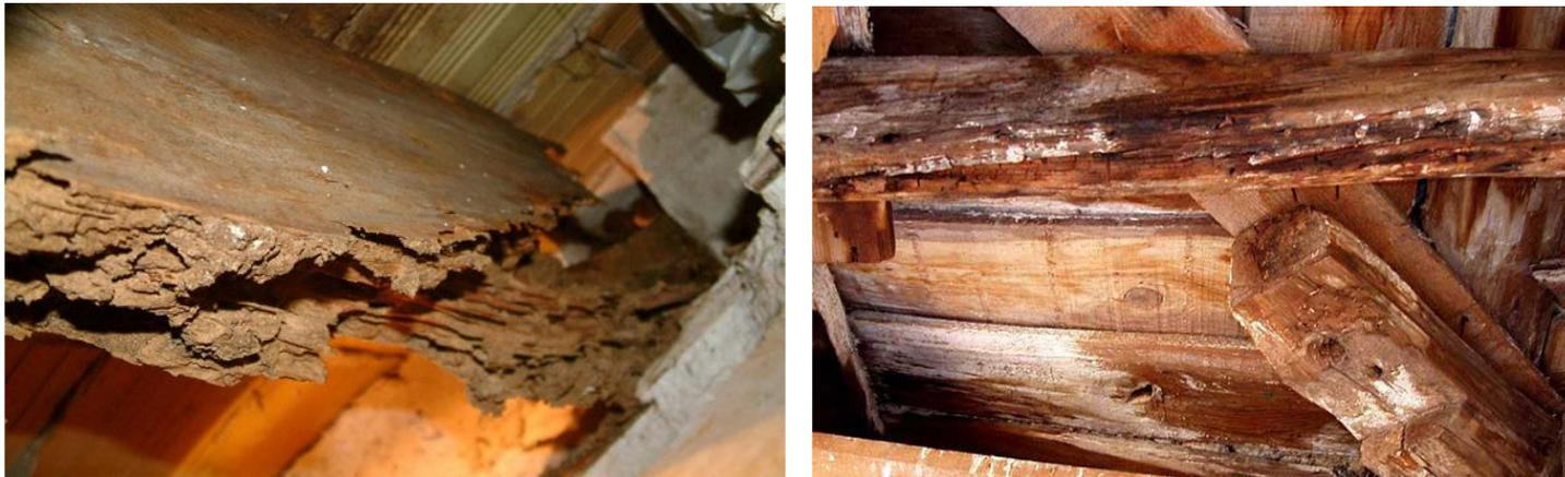
*Imagen 16 Desintegración de la madera y presencia de hongos causado por ambientes húmedos*
