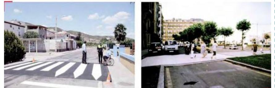
Imagen 38: A la izquierda, vista de un paso peatonal sobreelevado. A la derecha, vista de una acera continua. Fuente: CCE (2008)
