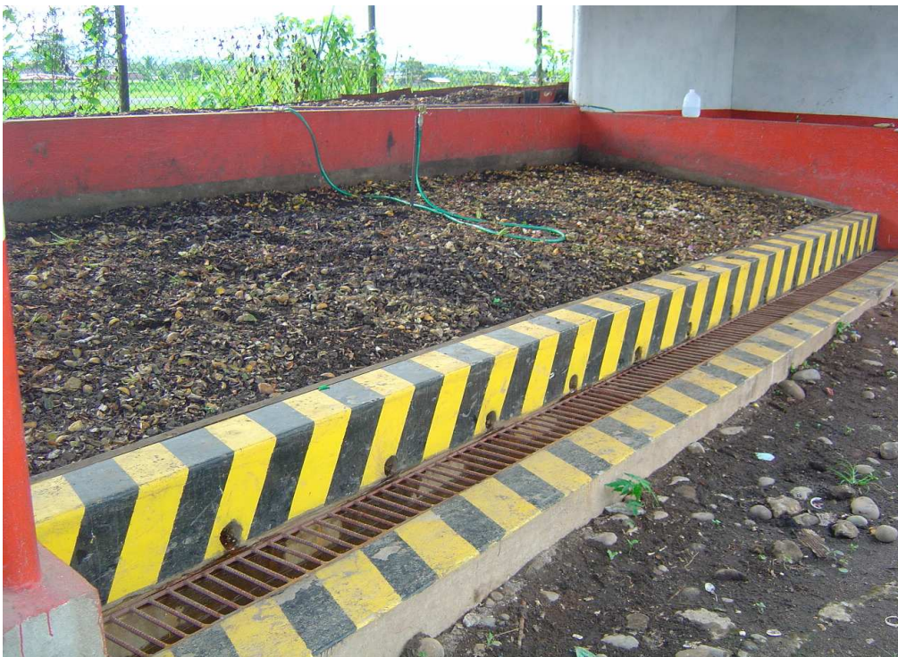
Fotografía 5 Lodos tendidos sobre una geomembrana para ser estabilizados
