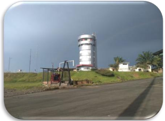
Torre de control
