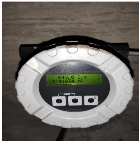
Figura 8: Dispositivo que regula el caudal de salida del sistema SCADA en la represa
