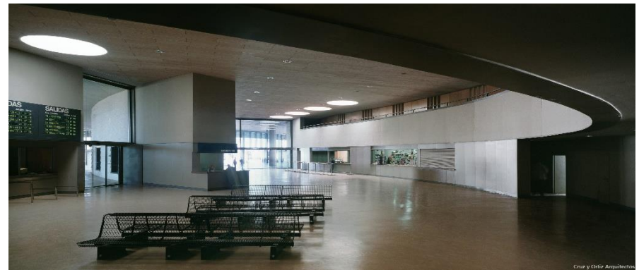
Imagen 22: Fotografía 2 estación de autobuses Huelva
