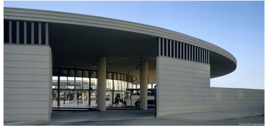
Imagen 27: Fotografía 7 estación de autobuses Huelva
