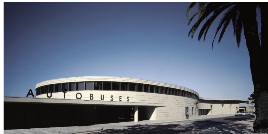
Imagen 25: Fotografía 5 estación de autobuses Huelva
