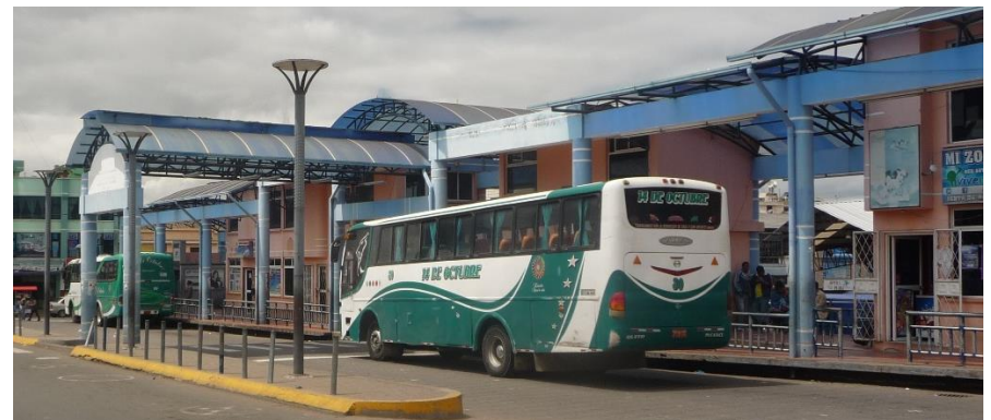
Imagen 14: Estructura y Materiales del Terminal Terrestre
