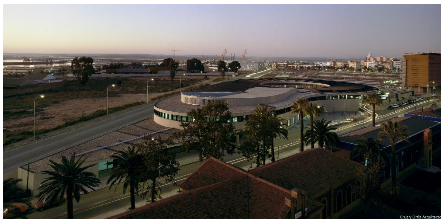
Imagen 21: Fotografía 1 estación de autobuses Huelva
