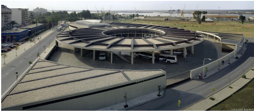
Imagen 26: Fotografía 6 estación de autobuses Huelva
