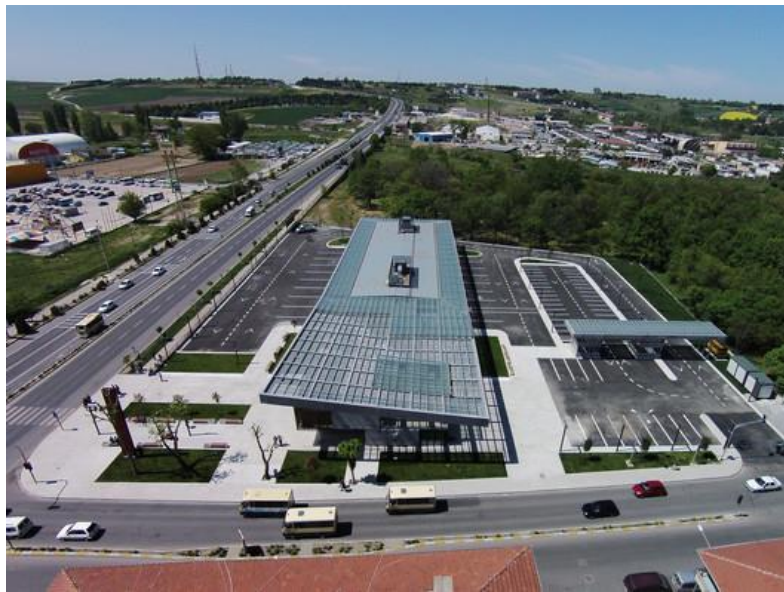
Imagen 15: Fotografía 1 estación de buses Lüleburgaz
