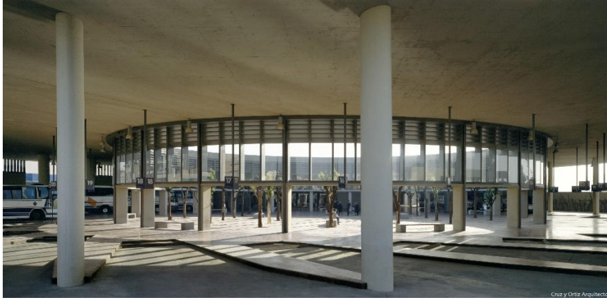
Imagen 24: Fotografía 4 estación de autobuses Huelva
