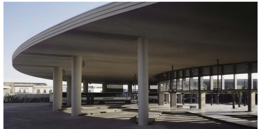
Imagen 28: Fotografía 8 estación de autobuses Huelva
