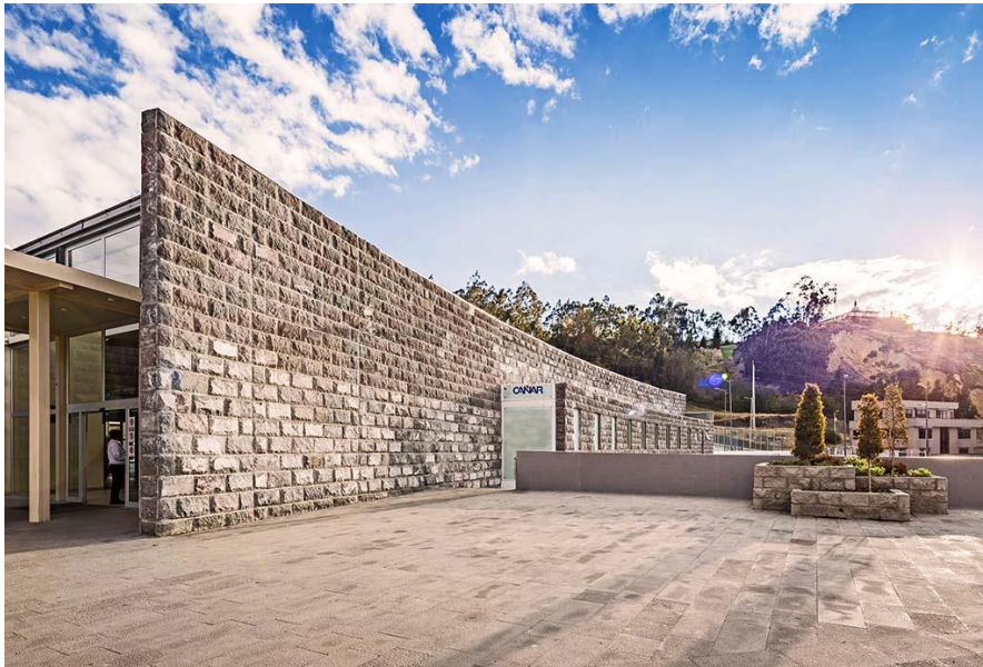
Imagen 32: Fotografía 4 Terminal Terrestre de Cañar
