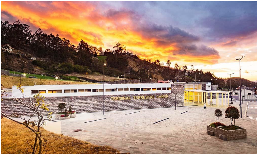
Imagen 29: Fotografía 1 Terminal Terrestre de Cañar
