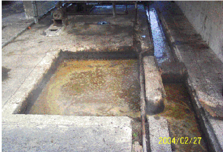
F13. Tanque desarenador
