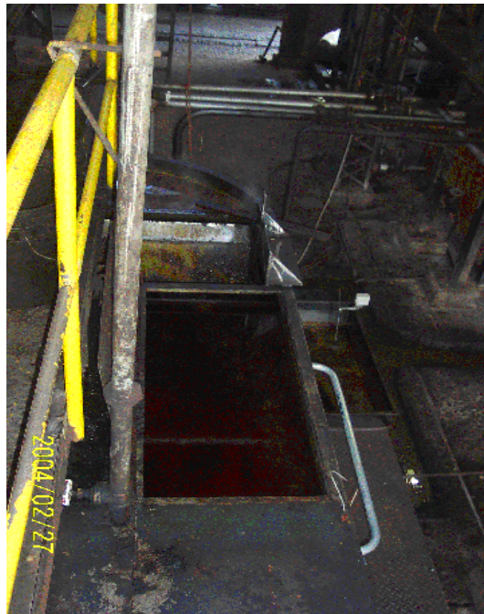
F10. Tanque de clarificación (separación agua aceite)
