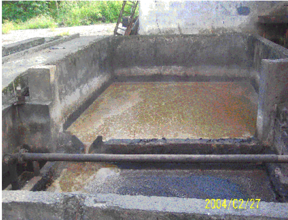
F15. Tanque sedimentador y Vertedero en “V”
