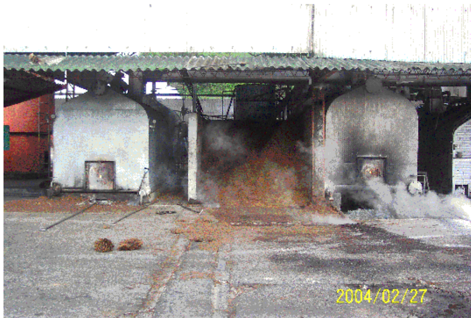
F4. Calderos de producción de vapor para autoclaves
