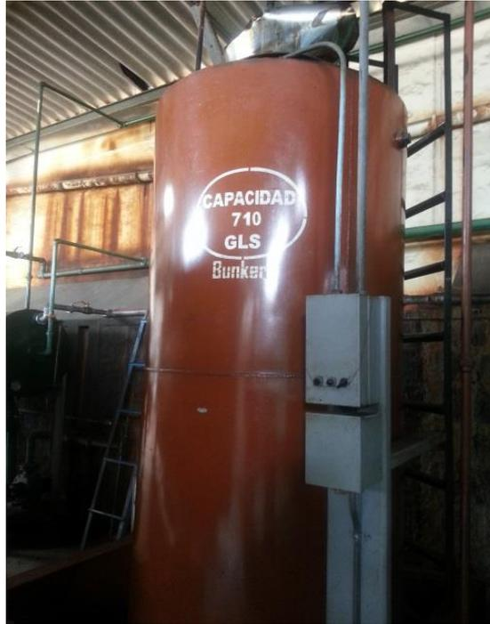
**Figura 5:** Tanque de Alimentación de Combustible (Empresa Textil, 2014)
