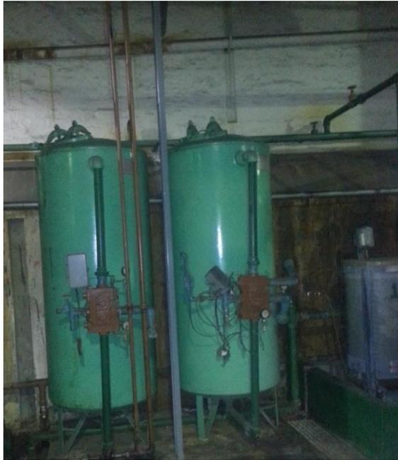
**Figura 3:** Sistema de tratamiento químico de dureza (Empresa Textil, 2014)
