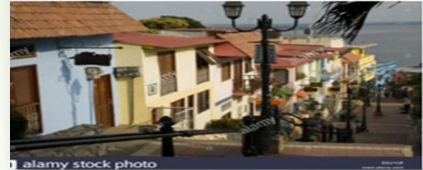
Dificultad -estructura tradicional
