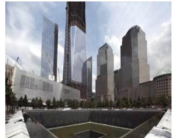
Imagen 1: Vistas Ground Zero Rescatado del 2019/08/22
