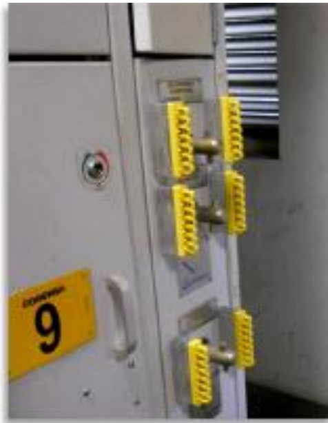
Montaje de Dispositivos.
