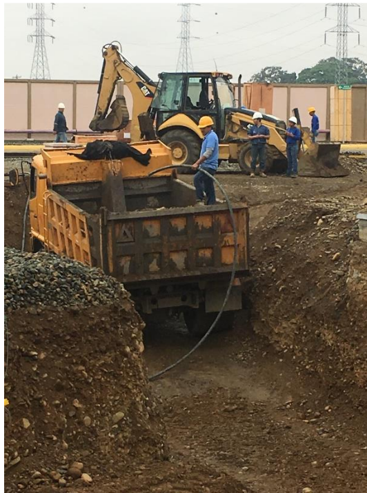
Foto 6. Movimiento de tierra para el ingreso de maquinaria
