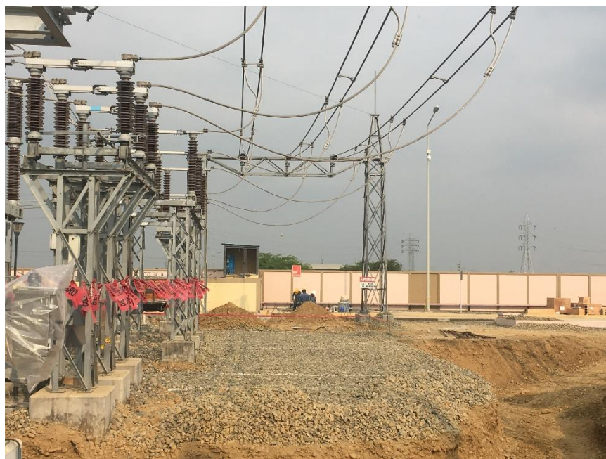
Foto 5. Movimiento de tierra para el ingreso de maquinaria
