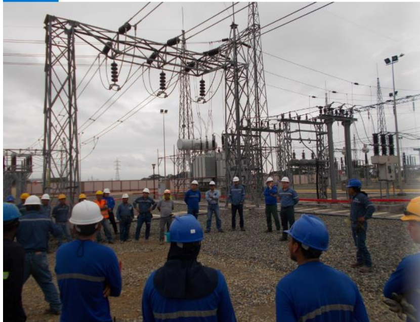
Foto 1. Charla de identificación de áreas energizadas y desenergizadas
