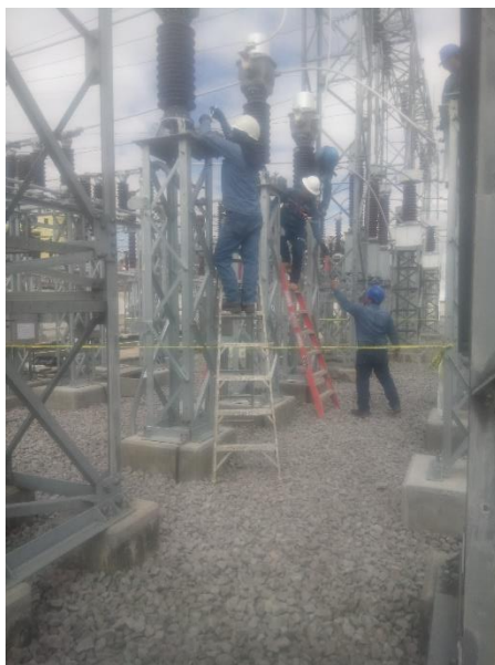
Foto 28. Delimitación de la zona de trabajo
