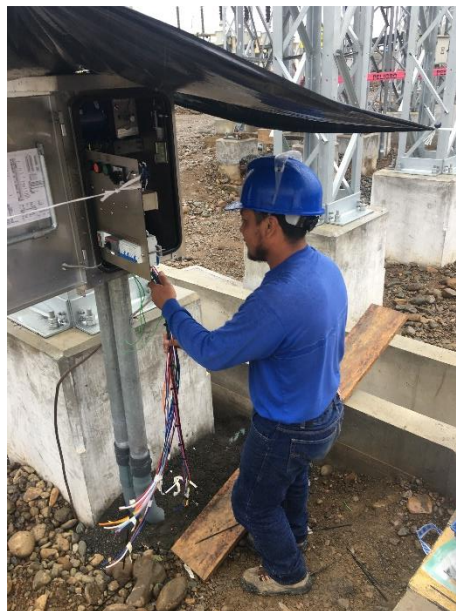
Foto 21. Conexionado y tendido de cables
