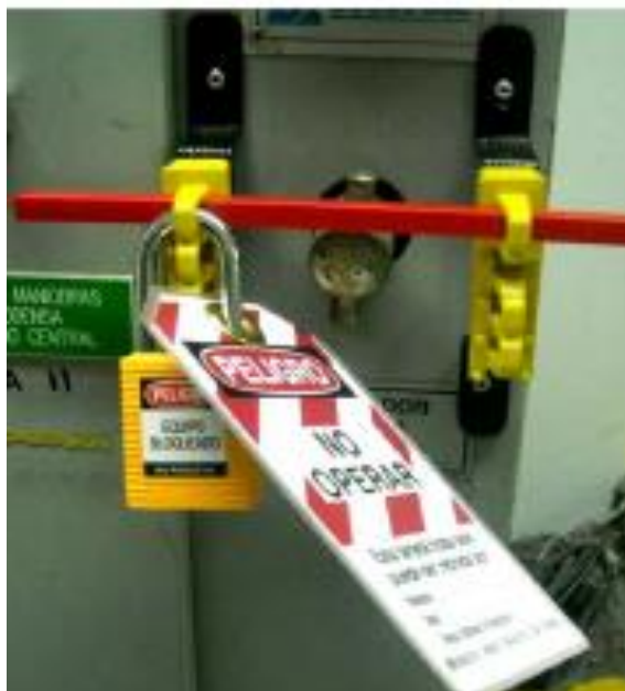
Seccionadores bloqueados para maniobra temporal.
