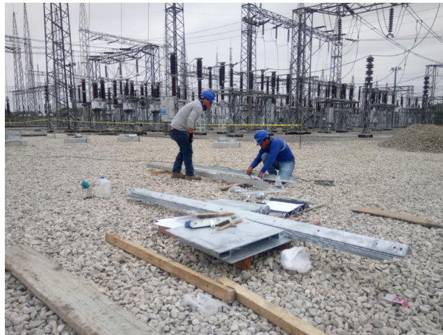
Foto 14. Verificación de estructura metálica
