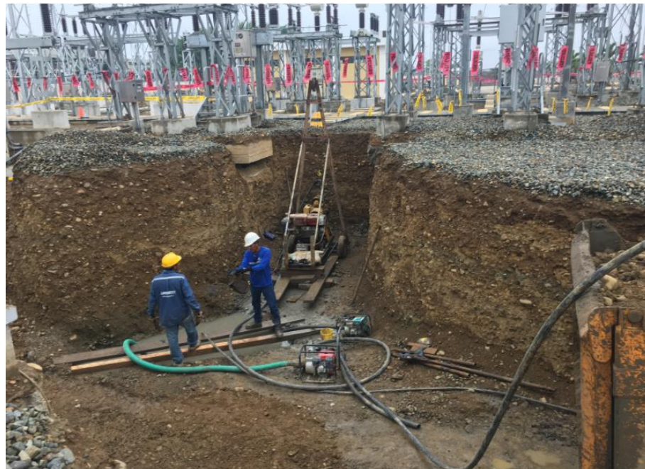
Foto 7. Movimiento de tierra para el ingreso de maquinaria
