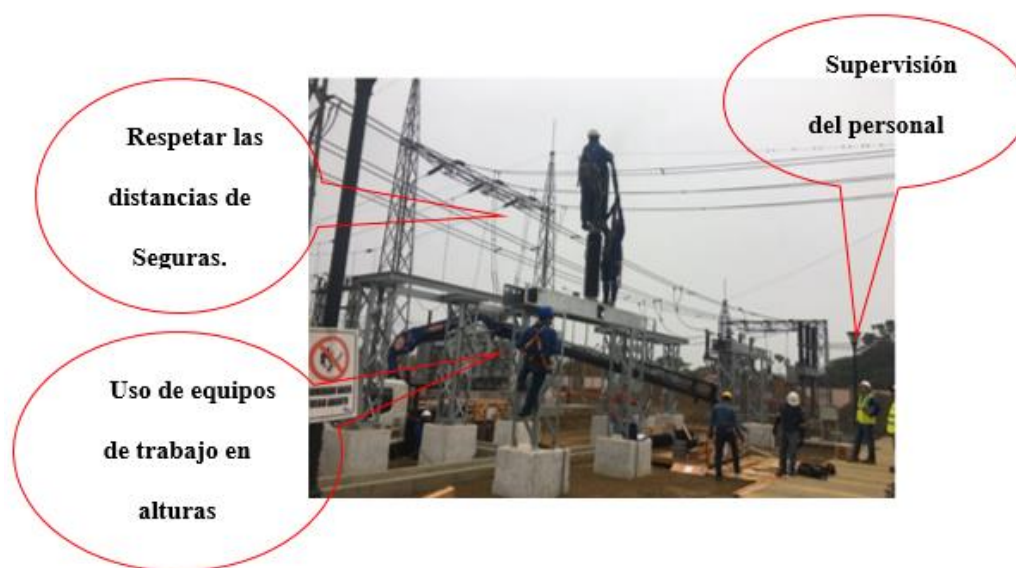
Foto 17. Montaje de equipos
