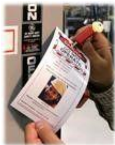
Figura # 14. Bloqueo y etiquetado (2)
