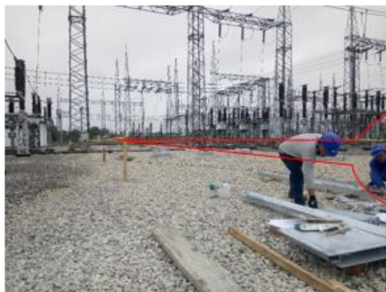
Foto 15. Señalización de la zona de trabajo
