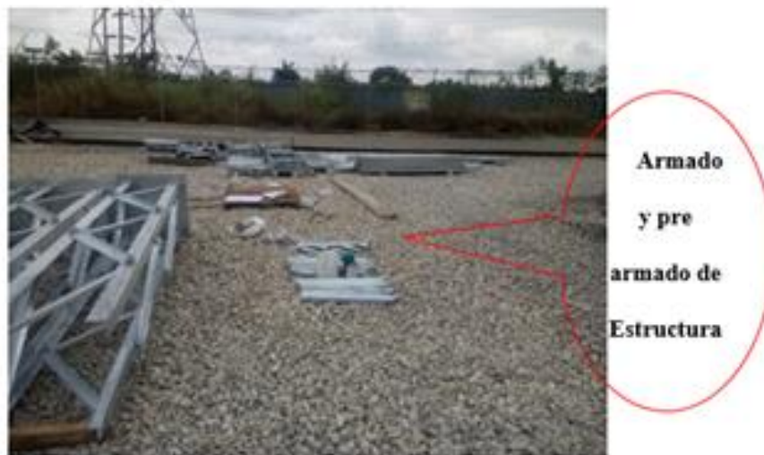
Foto 16. Abastecimiento y pre armado de estructura metálica
