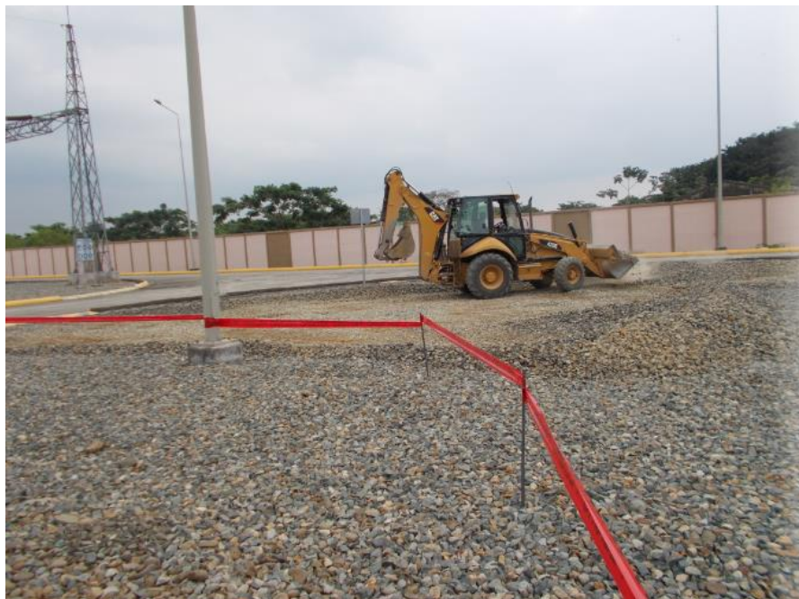
Foto 4. Movimiento de tierras para el ingreso de maquinaria
