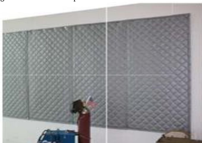
Figura N° 5: Modelo de paneles de absorción acústica línea de corte
