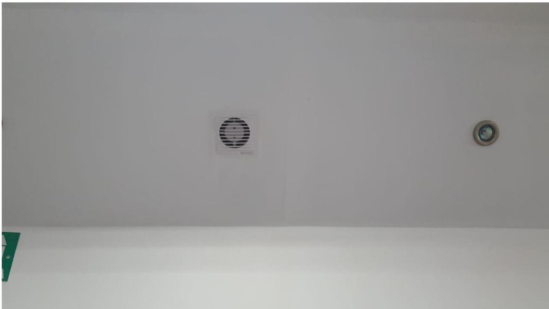
Sistema de ventilación general en el área de análisis de muestras biológicas para evitar aerosoles y malos olores.
