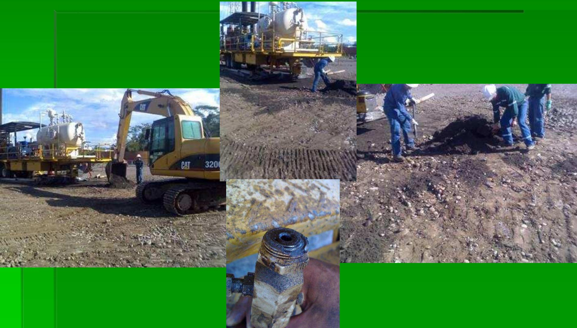
Se produjo un accidente ambiental el al locación Sacha Norte 2 de Petroproducción en el pozo Sacha 178 D, en la cual aproximadamente a las 3 de la tarde se presenta una fuga de fluido por en el separador por una ruptura del bussing de  $\frac{3}{4}$  a  $\frac{1}{2}$  a el cual se halla instalado una válvula de aguja y esta al manómetro de presión del separador, el mismo que en el momento de la contingencia presentaba una presión de 100 PSI
