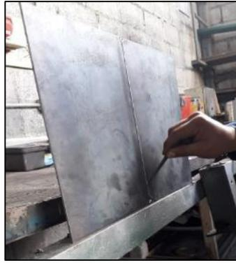
Fijación de placa a soldar; verificación de medidas y apertura para soldeo
