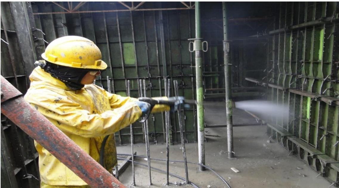
FOTO 19 Proyecto Hacienda Pinsaquí. Lavado a presión de agua para retirar residuos de hormigón.
