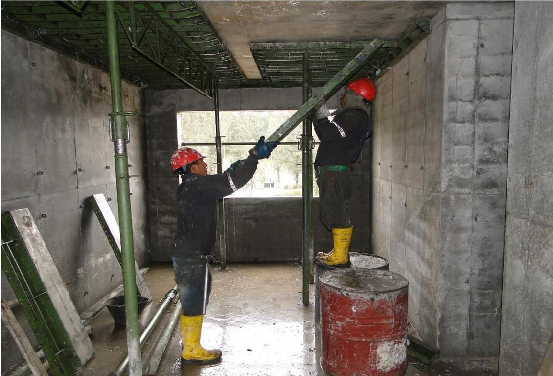
FOTO 22 Proyecto Hacienda Pinsaqué. Proceso de desencofrado.
