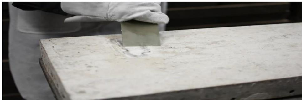
FOTO 31 Imagen Video Metalex. Limpieza de residuos de hormigón en superficie de formaleta.
