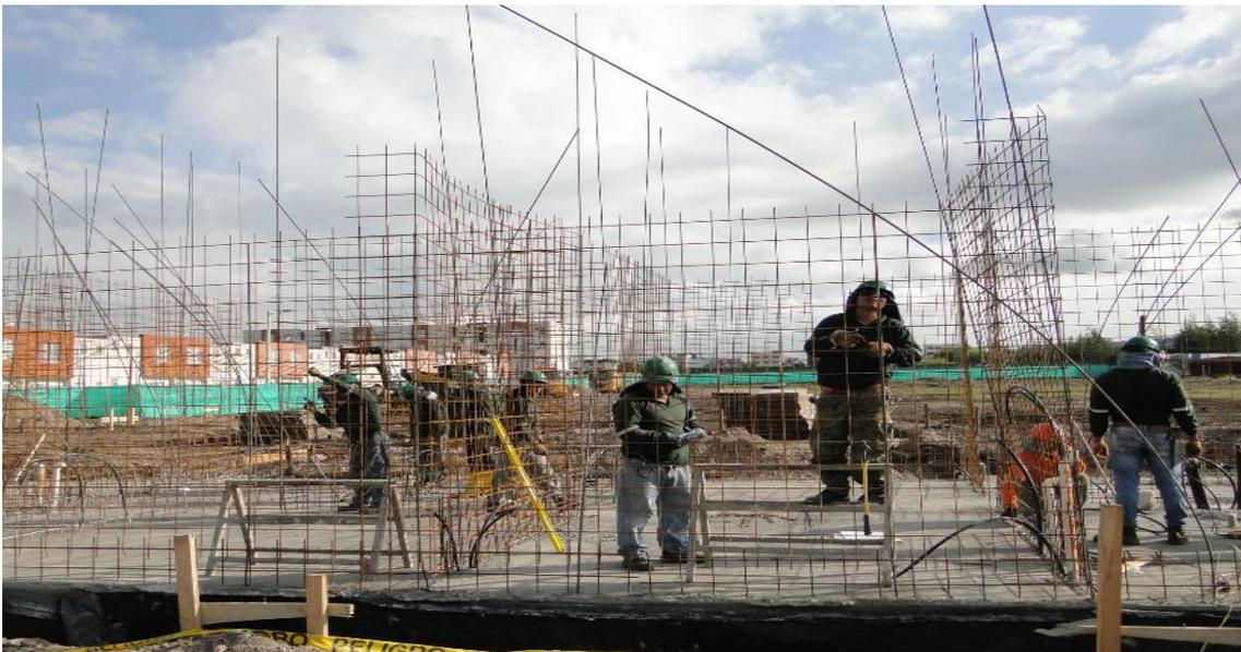
FOTO 3 Proyecto Hacienda Pinsaquí. Armado de malla electrosoldada.
