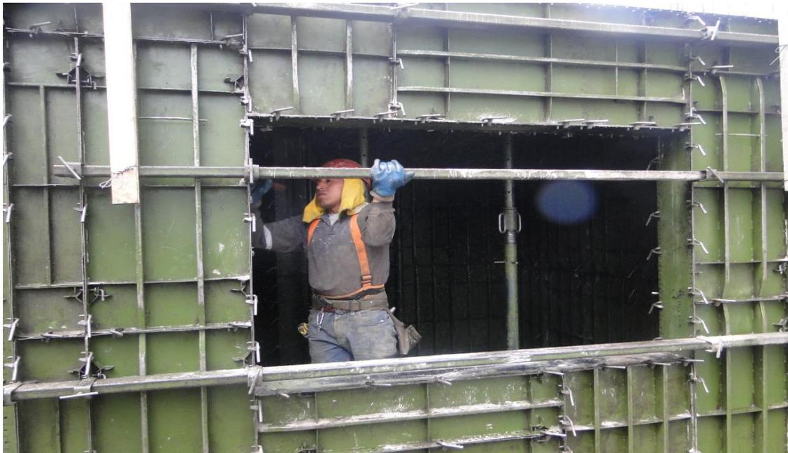
FOTO 12 Colocación de alineadores y tensores. Para ajuste de estructuras.
