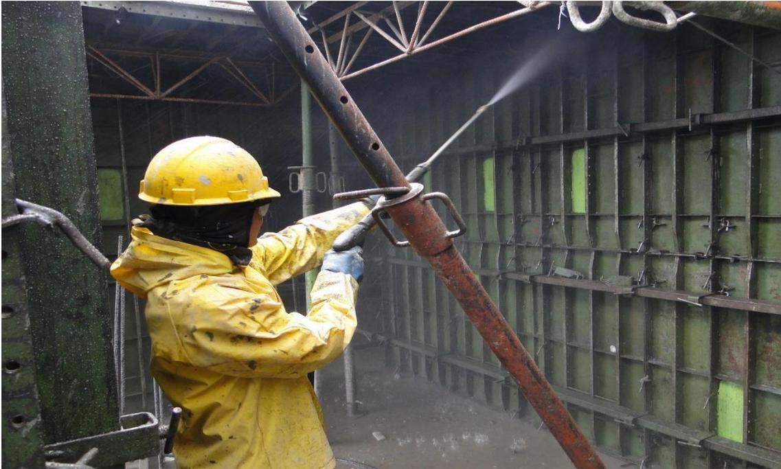
FOTO 20 Proyecto Hacienda Pinsaqué. Lavado de estructura armada. Previo a fundición.
