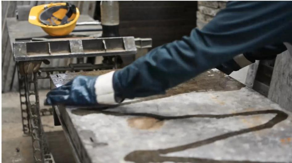
FOTO 45 Imagen Video Metalex. Cobertura de la superficie de formaleta por desmoldante.
