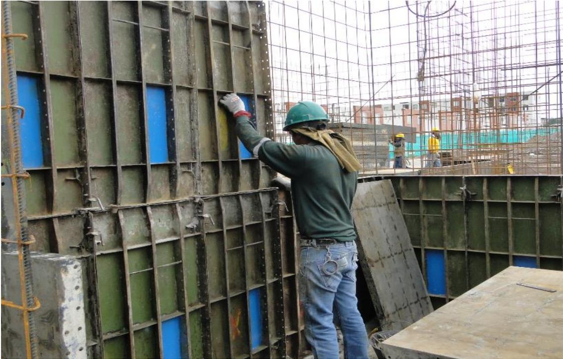
FOTO 8. Proyecto Hacienda Pinsaqué. Estructurado de muros cajón.
