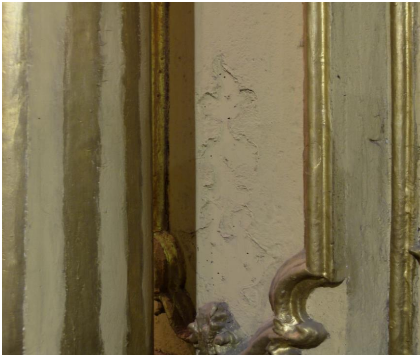
Repintes y faltante de tallas/ deterioro similar en este tipo de retablos
