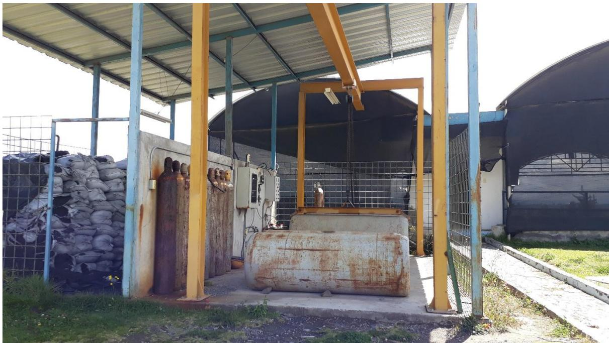
**Fotografía 10:** Tanque de cloración
