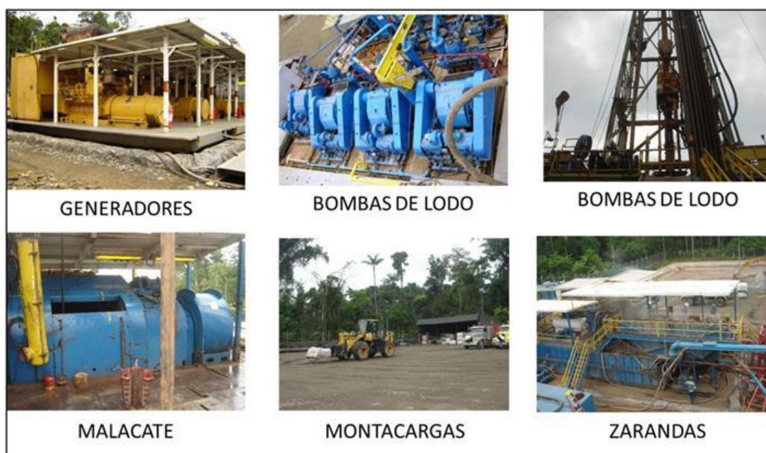
Ilustración 26: Equipos utilizados en trabajos para taladros de perforación
