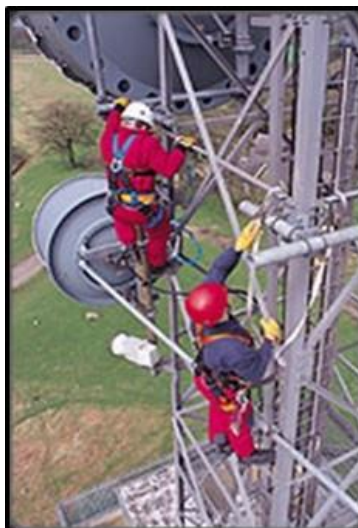
Ilustración 1: Trabajos en altura
