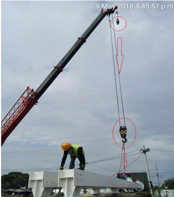
**Figura 19 Actividad en donde se procede a aparejar la carga y colocar el viento o cabo**
