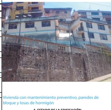
Vivienda con mantenimiento preventivo, paredes de bloque y losas de hormigón
