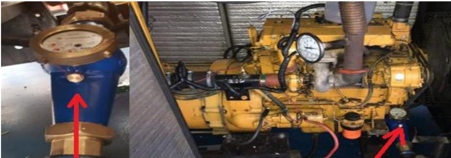
Figura 6. Medidor de Agua Corro Múltiple de 2pug.
