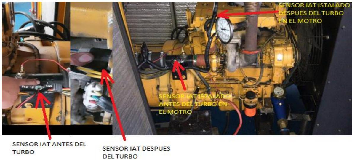
Figura 7. Sensor IAT Instalado en el Motor Caterpillar.
