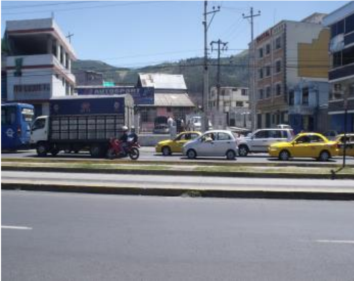
Vista de ambos carriles de la Avenida Mariscal Sucre.
