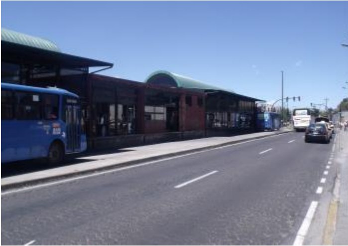
Estación de la Ecovía "El Capulí", vista desde Keramicos.
