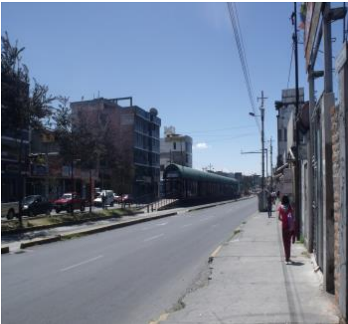
Vista de la estación del Corredor Sur Occidental "Mena 2".
