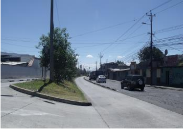
Avenida Pedro Vicente Maldonado carril S-N vista desde el parterre.
