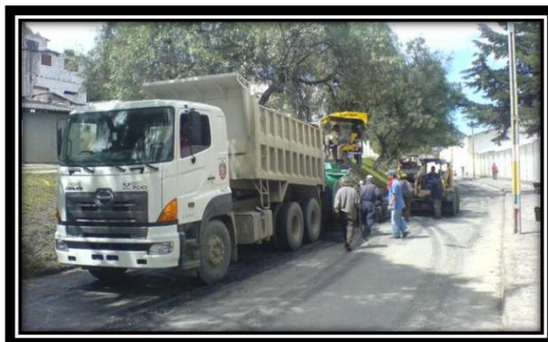
Para construir la parte superior de un pavimento flexible dosificado en planta se usan equipos de diseño especial, los cuales extienden la mezcla caliente que reciben de los camiones. Estos equipos se conocen como pavimentadoras, esparcidoras o terminadoras (Finisher).
