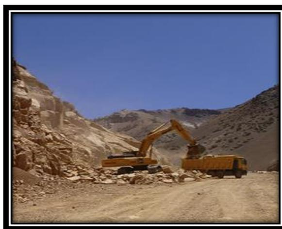
Todos los materiales que ingresan y salen de la planta son inspeccionados por un controlador que firma la entrada y salida para llevar un control estimado, debido a que los volquetes no son pesados en básculas si no que son cubcados con las dimensiones que poseen en el balde del mismo.
