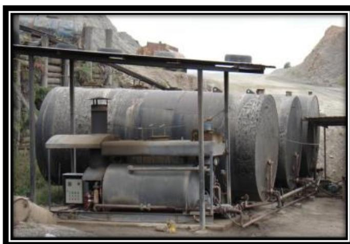
El objetivo del sistema es entregar por medio de una bomba de inyección el cemento asfáltico a la planta de producción a una temperatura de trabajo que varía de 120 a 150°C, en una producción que corresponde a la cantidad de kilos por metros cúbicos planteada en el diseño.
