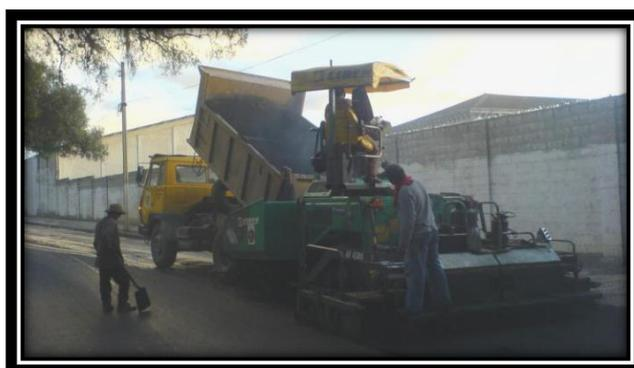
Después de haber esparcido la mezcla asfáltica y alisada las irregularidades de la superficie, es compactada adecuadamente por medio de rodillos. La compactación se realiza inmediatamente después de la colocación de la mezcla, cuando esta acepte el peso de la aplanadora sin que se produzcan deformaciones ni desplazamientos excesivos esto se logra cuando la temperatura de la mezcla oscila entre los 110 a 120 °C.
