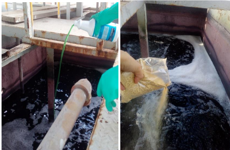
Figura 10. Reactor biológico - Siembra de bacterias
