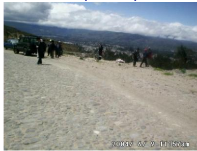
Calzada empedrada seca.
