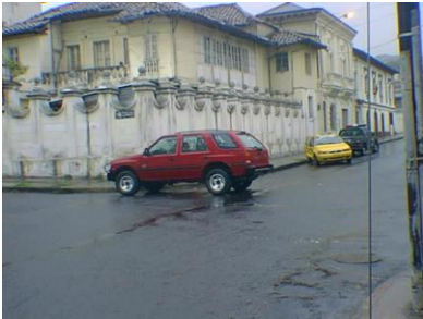
Calzada asfaltada, mojada
