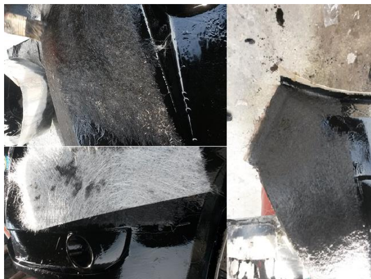
Figura 21. Proceso de colocación manual de la fibra de vidrio
