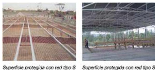
**Figura 12 Montaje de red “Tipo S”**
