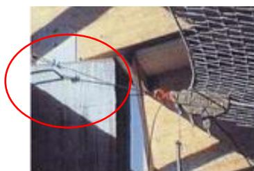
*Cable metálico con dispositivo de enganche y de tensado*
