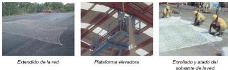
**Figura 11** Instalación de red “Tipo S”
