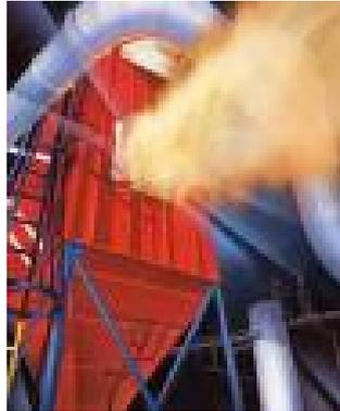
**Figura 05.1.** *Sistemas de venteo de explosiones*
