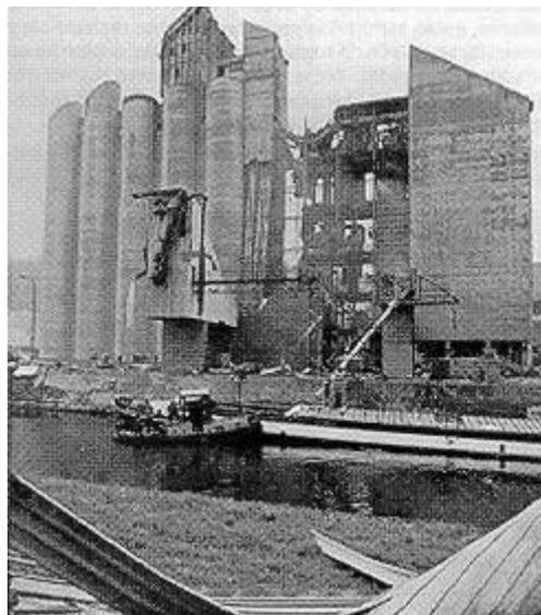
**Figura 01.1.** Efectos de la explosión de polvo en un silo de maíz
