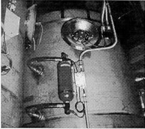
**Figura 05.10.** Sistema de supresión de explosión instalado en un ciclón
