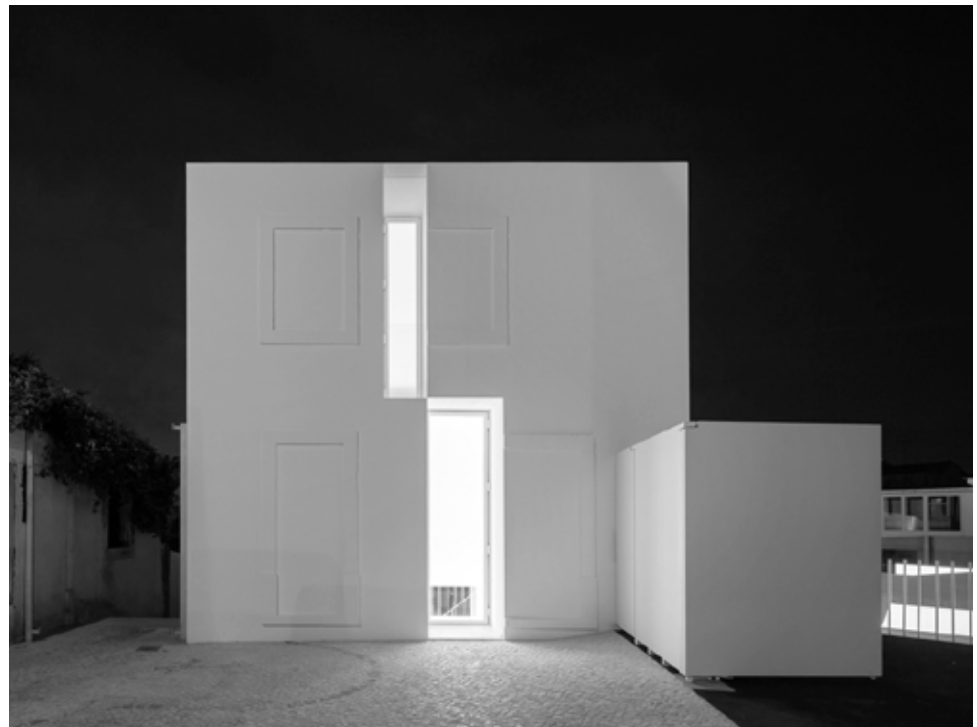
Recuperado de https://www.plataformaarquitectura.cl/cl/785829/casa-en-alcobaca-aires-mateus
