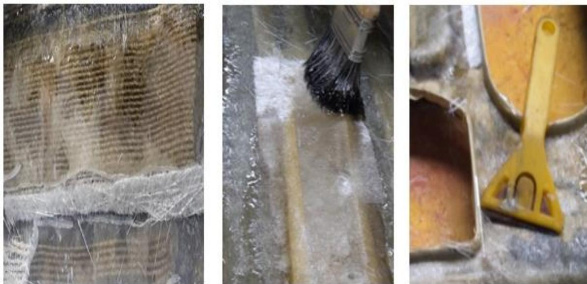
*Figura 52.* Aplicación de la tercera capa de fibra de vidrio.
