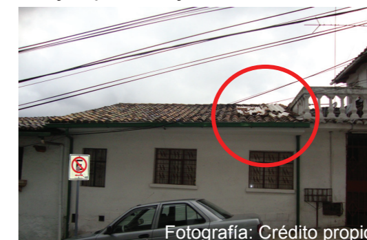
26 Ejemplo de tejas en mal estado
