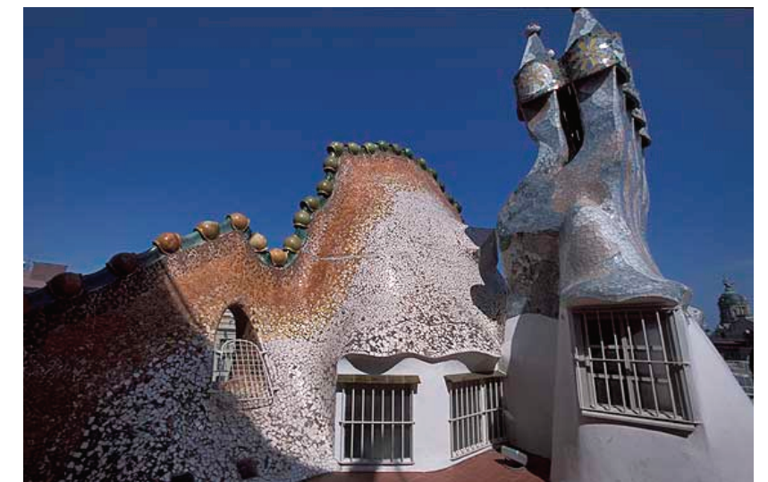
Fotografía: www.kirikou.com/monograficos/gaudi/Casa_Batllo.htm 7 vista de la cubierta de la casa Batlló donde se aprecia la una forma orgánica cubierta con tejuelo de colores simulando ser escamas.
