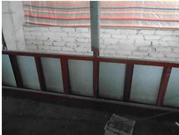
**Figura 67.** Pared lateral antes de aplicar poliestireno expandido.
