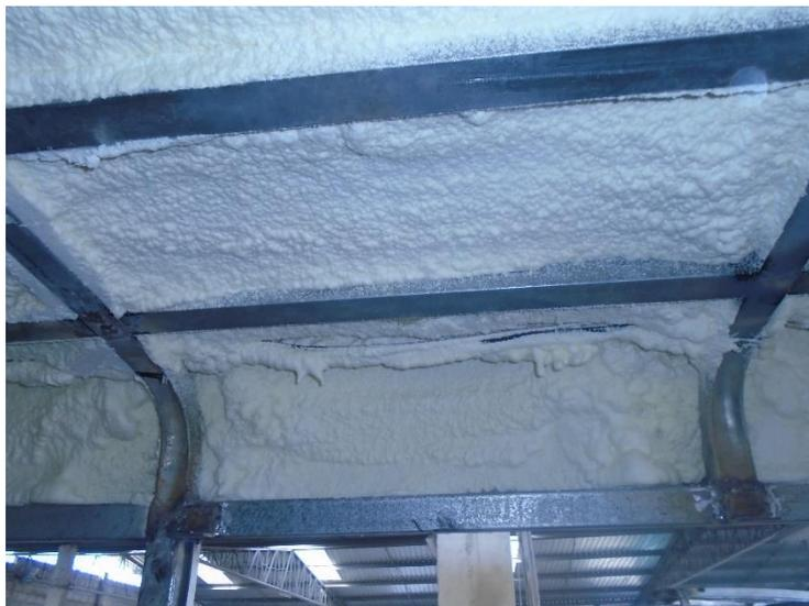
**Figura 61.** Aplicación de espuma de poliuretano en el techo
