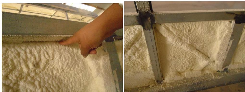
**Figura 63.** Espuma de poliuretano pared lateral      Fuente: Autor
