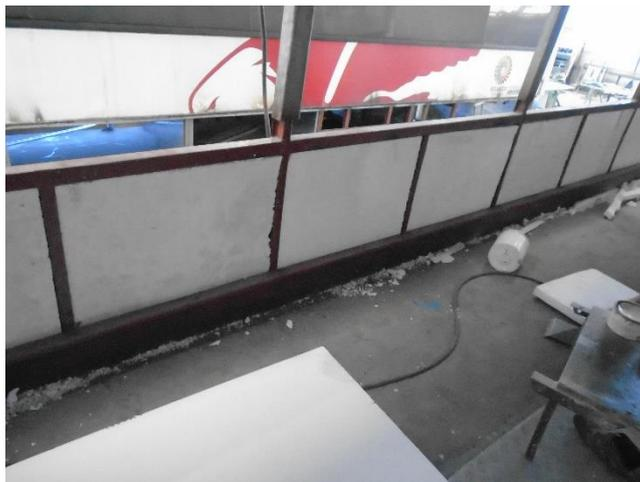
**Figura 68.** Pared lateral aplicada poliestireno expandido
