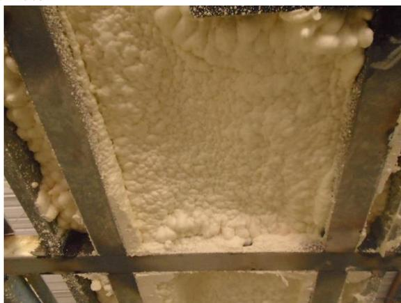
**Figura 62.** Espuma de poliuretano en el techo
