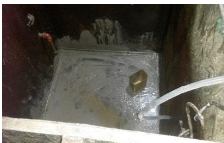
Figura 5: Mantenimiento del Tanque de Lavado Autor: Luna, 2016
