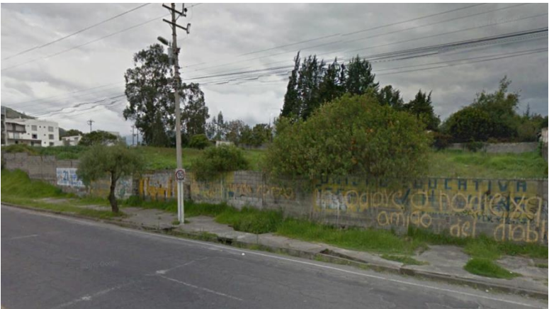
Gráfico 61. Espacio público deteriorado
