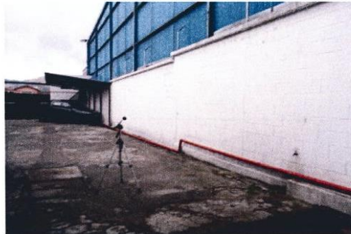
Fotografía 3. Medición de ruido Punto 3. Ubicado dentro de la fábrica INDUTEXMA
