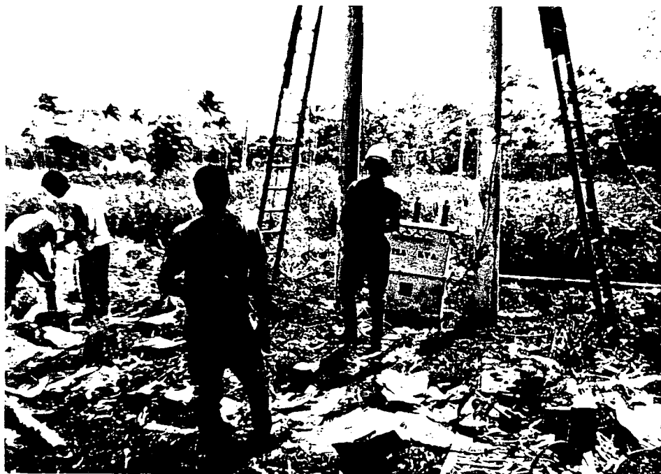
HOMBRES TRABAJANDO EN TRANSFORMADOR
