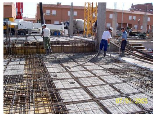
FIG.6 – Sistema de hormigón armado + Sistema de losas bidireccionales – Fuente: [www.construmatica.com](http://www.construmatica.com)
