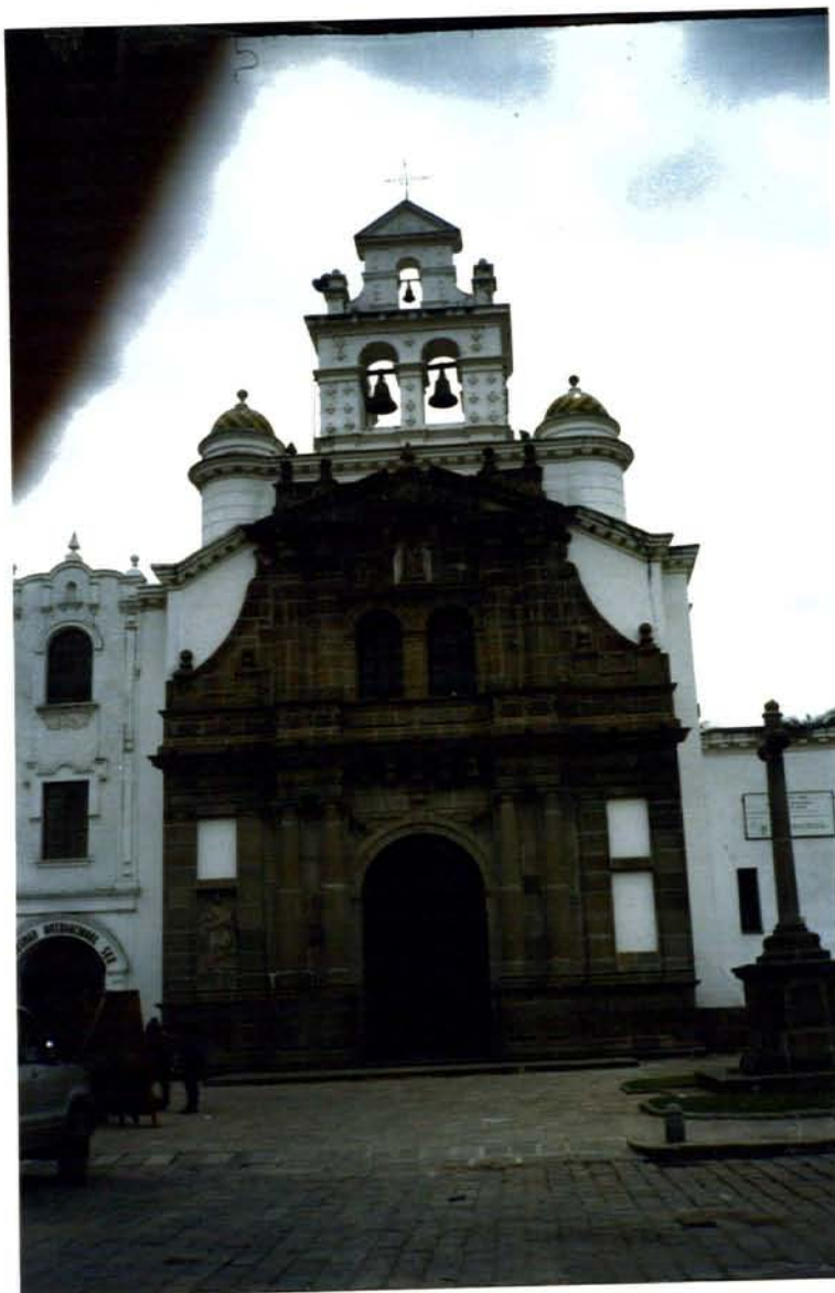
Figura # 6. Frontis o fachada
