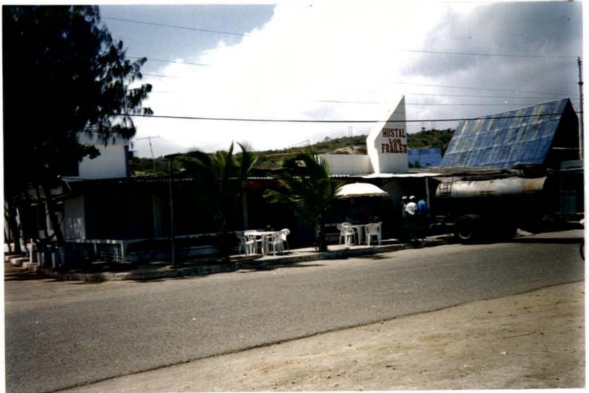
INFRAESTRUCTURA HOTELERA. PUERTO CAYO.
