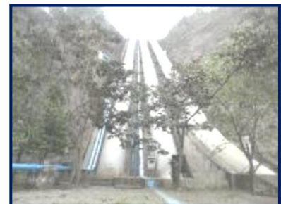
Tubería de Presión
