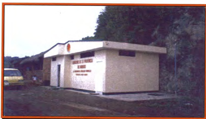
FOTOGRAFÍA 8: BATERIAS SANITARIAS PUBLICAS CERCANAS A LA PLAYA FUENTE: ARCHIVOS DEL MUNICIPIO DE JAMA
