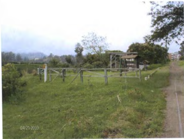
VISTA OESTE / LINEA FERREA (F5)
