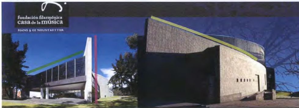
Vista Exterior de La Casa de la Música
