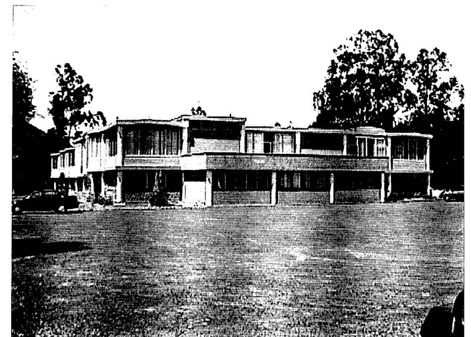
FOTO 4 (fachada sur bloque 1)
