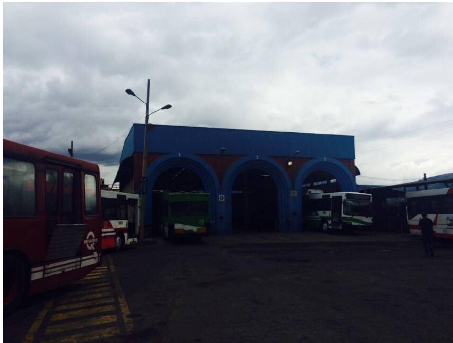
Figura 31. Área de pintura
