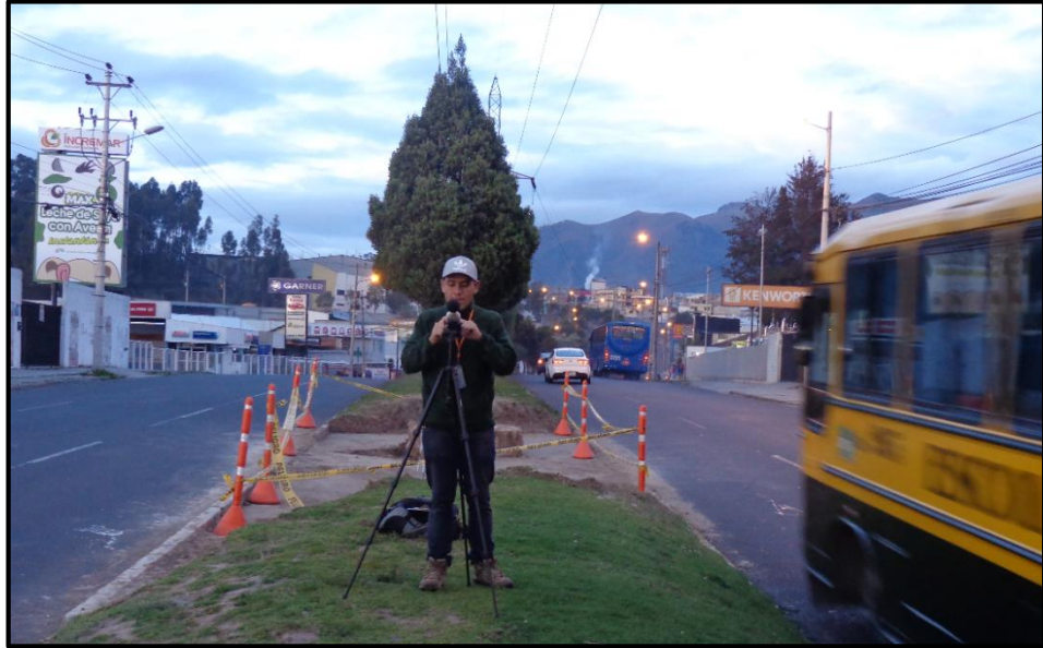
OBRAS VIALES ESTACIÓN N°:3 Vista Norte – Sur
