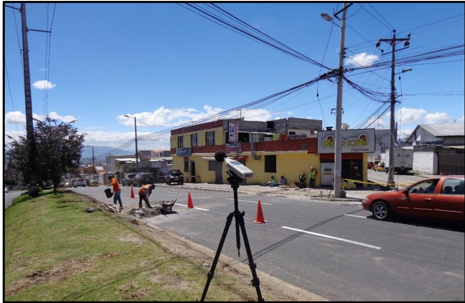
OBRAS VIALES ESTACIÓN N°:3 Vista Oeste – Este
