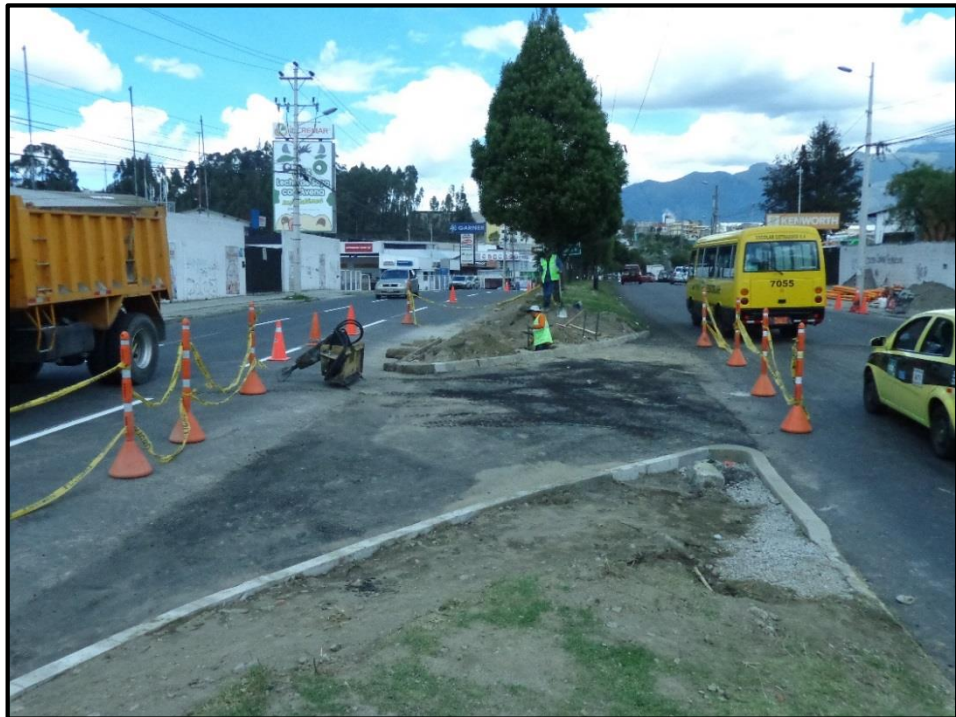
OBRAS VIALES ESTACIÓN N°:3 Vista Norte – Sur
