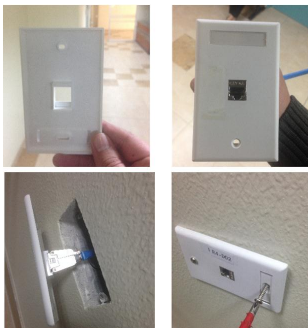
Figura No. 30: Conexión o ponchado del cable FTP en el conector rj-45 hembra de pared.
