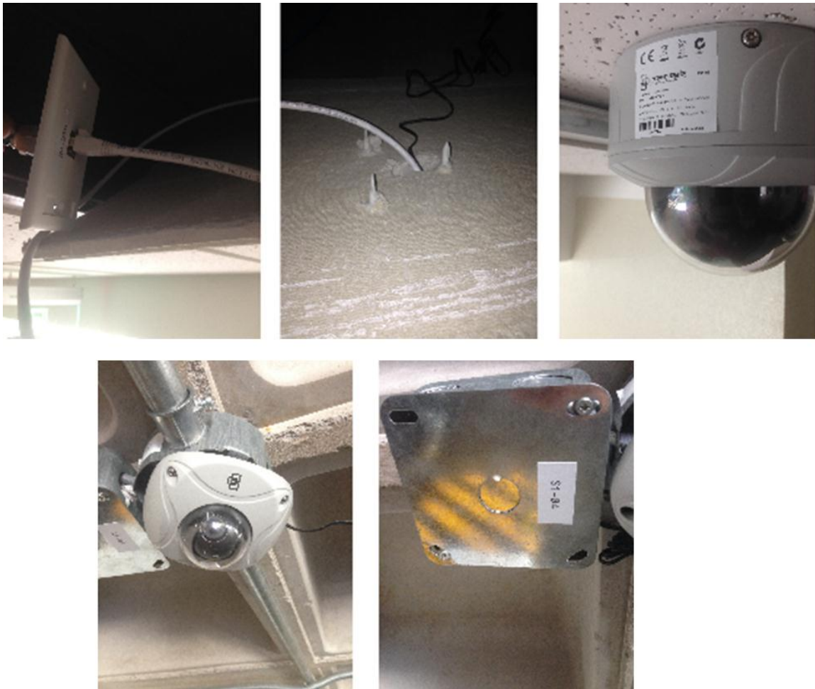
Figura No. 37: Instalación de cámaras IP.
