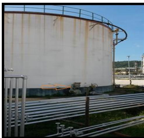
En la figura 5 se hace notar el motor que acciona las hélices dentro del tanque de slop, cerca de este mecanismo se encuentra la línea de salida del producto del tanque de slop. Las especificaciones técnicas se presentan en la siguiente tabla:
