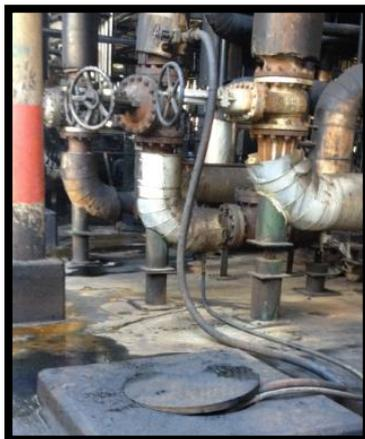
En la figura 3 se puede apreciar una manguera de caucho acoplada entre la línea operativa y el manhole aceitoso con su respectiva tapa metálica, por lo tanto por condiciones de mantenimiento se debe drenar el hidrocarburo de la línea de operaciones hacia la red aceitosa, de no ser así, el hidrocarburo contenido en la línea de operación debería dejarse caer al piso lo cual ocasionaría contaminación del área.
